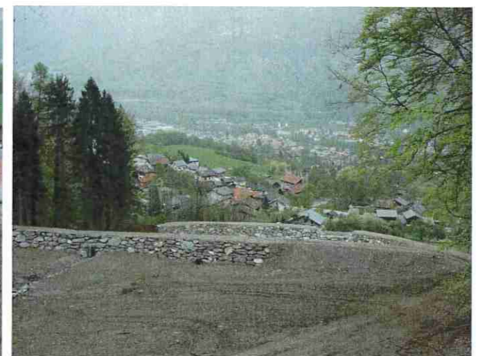
Plage supérieure, déversoir dans la plage aval
